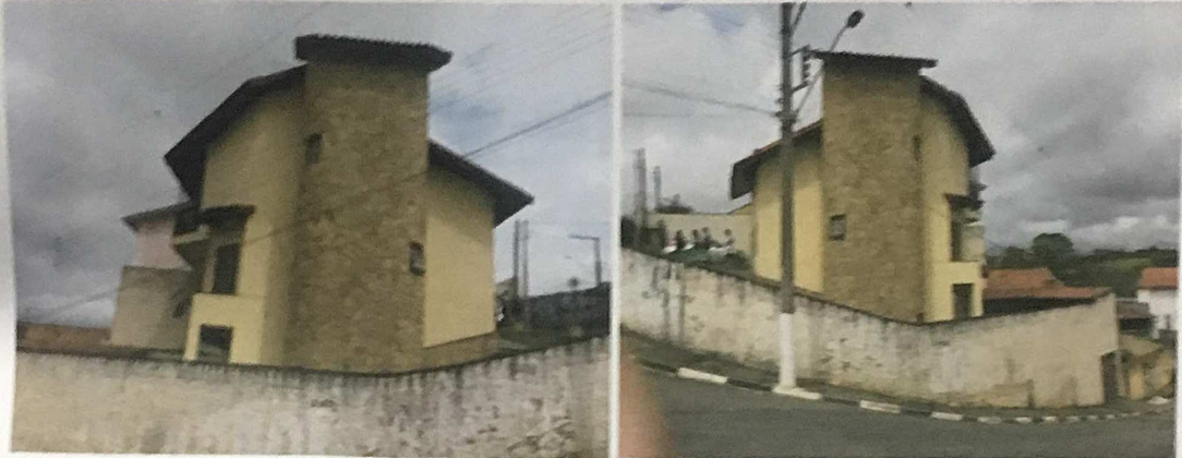
(LATERAL DO IMÓVEL)
