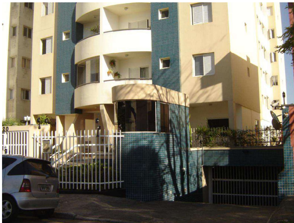
Vista da entrada da entrada social e dos veículos do Edifício Pacajás
