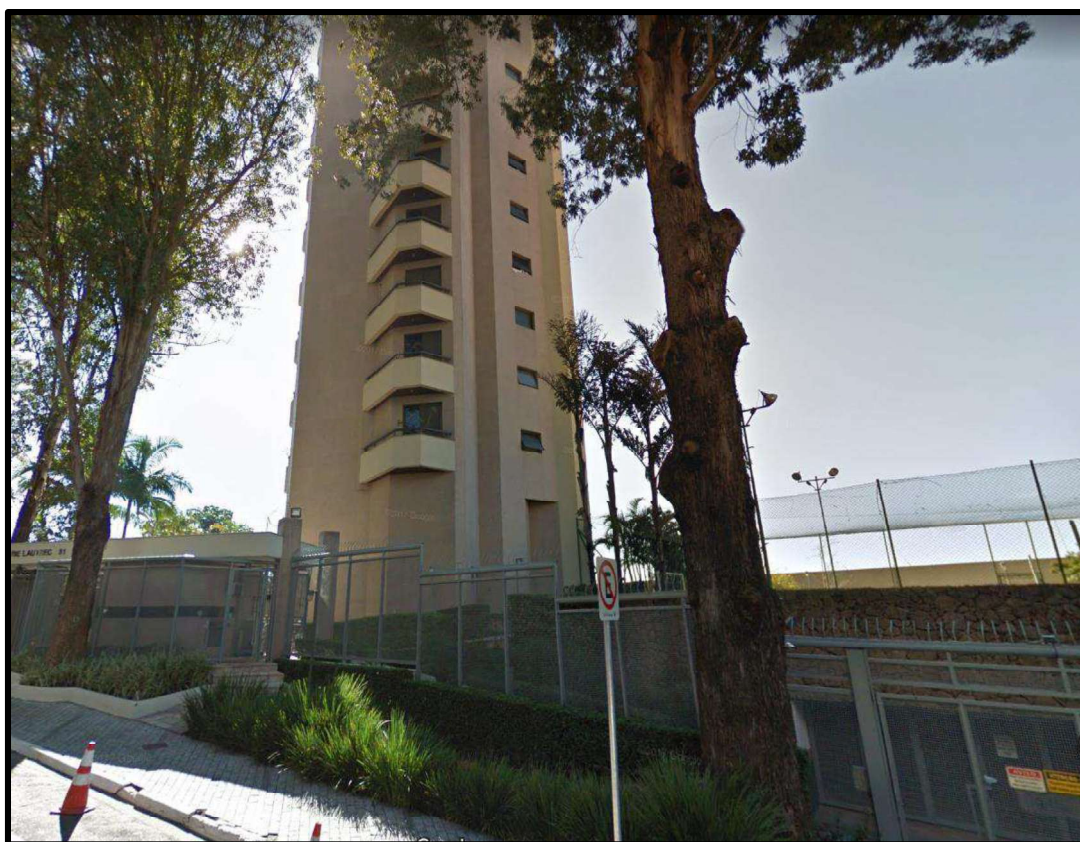
Foto 1: Fachada do imóvel
