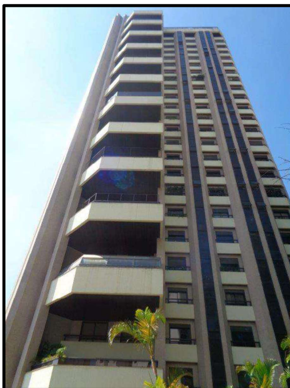
Foto 2: Fachada do prédio
