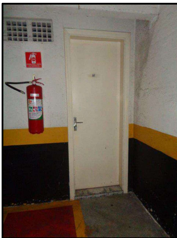
Foto 21: Depósito do apartamento 81
