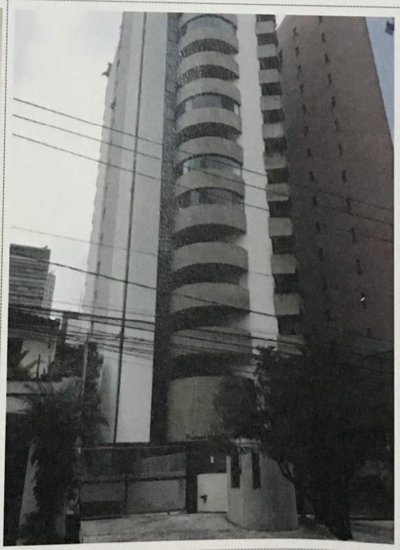
Fachada do prédio
