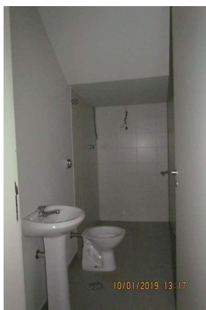
WC na garagem
