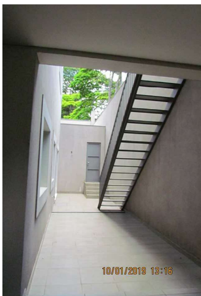
Acesso da garagem para o piso térreo
