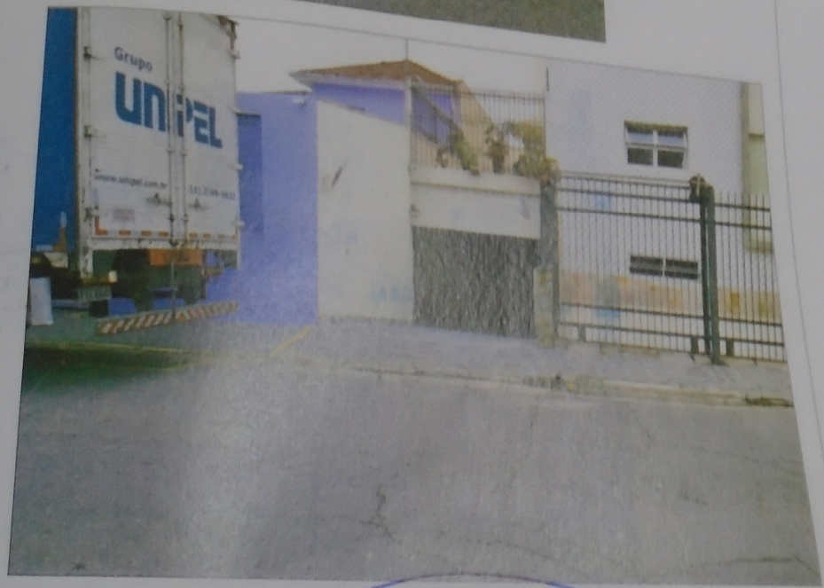
O acesso de veículos pela rua Alcacer-Kehir.
