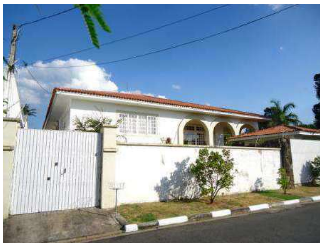
VISTA DAS CONSTRUÇÕES ERGIDAS SOBRE O TERRENO.
