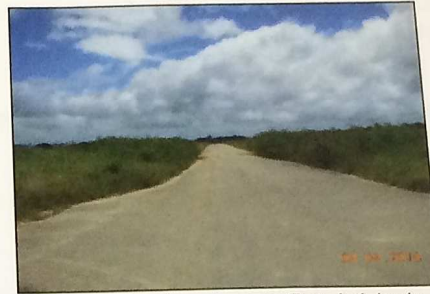
Imagem 3 – Acesso para Rua Asfaltada
