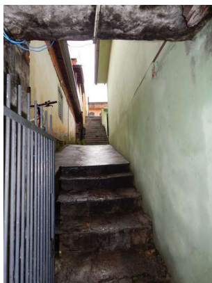
31 - DSCN2217.JPG Acesso casas 2 e 3 - Escada lateral.
