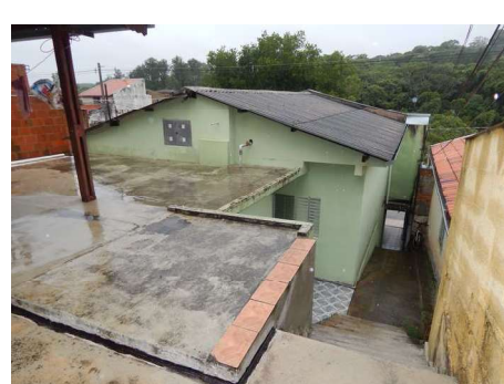
36 - DSCN2263.JPG Casa 2 - Escada de acesso.
