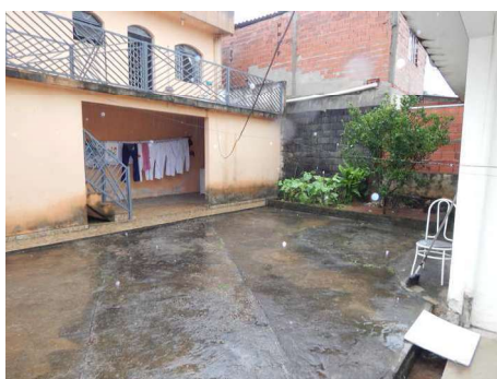
35 - DSCN2221.JPG Acesso casas 2 e 3 - Região entre as casas 2 e 3.
