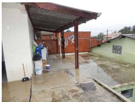
37 - DSCN2264.JPG Casa 2 - Lavanderia.
