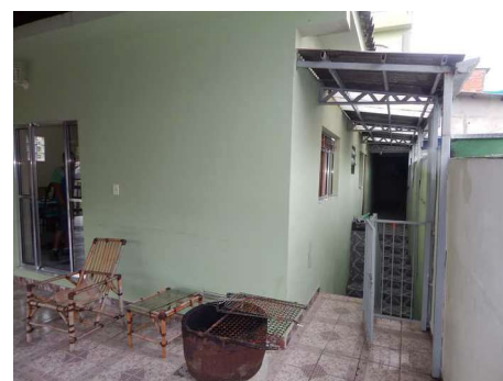
06 - DSCN2291.JPG Casa 1 - Acesso à sala e varanda frontal.
