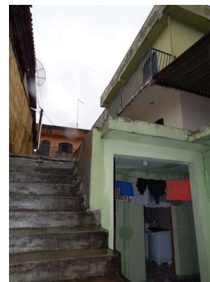
33 - DSCN2219.JPG Acesso casas 2 e 3 - Escada lateral.
