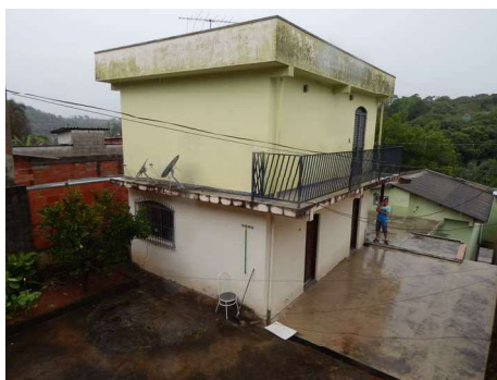
38 - DSCN2249.JPG Casa 2 - Fachada.
