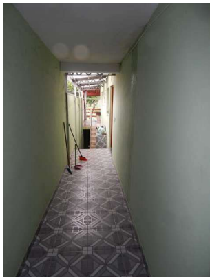
25 - DSCN2270.JPG Casa 1 - Corredor lateral.
