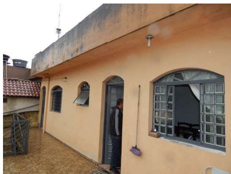
55 - DSCN2227.JPG Casa 3 - Fachada.
