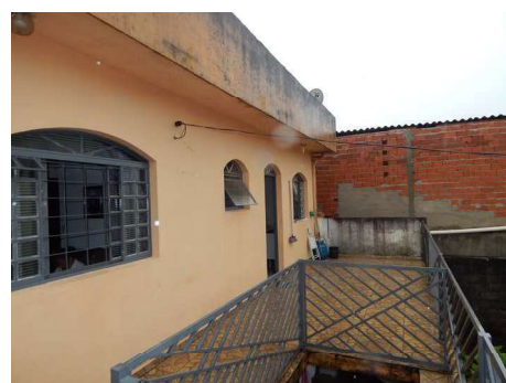
54 - DSCN2226.JPG Casa 3 - Fachada.
