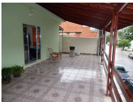
08 - DSCN2289.JPG Casa 1 - Varanda.
