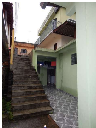
32 - DSCN2218.JPG Acesso casas 2 e 3 - Escada lateral.
