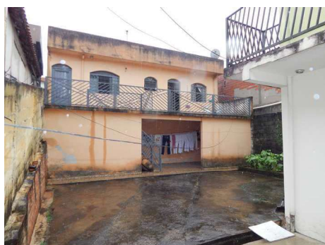
34 - DSCN2220.JPG Acesso casas 2 e 3 - Região entre as casas 2 e 3.
