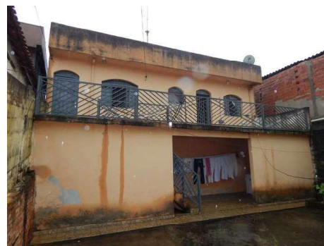
51 - DSCN2222.JPG Casa 3 - Fachada.
