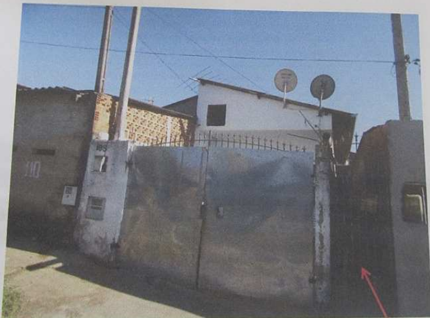
Fachada de nº 108 e 108 fundos, acesso pelo portão lateral.
