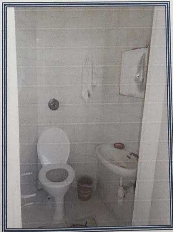
Banheiro de empregada.
