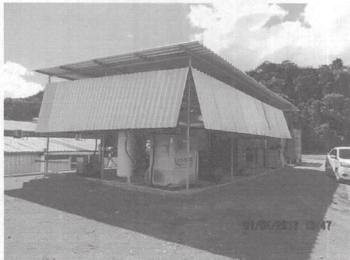
Cobertura de equipamentos
