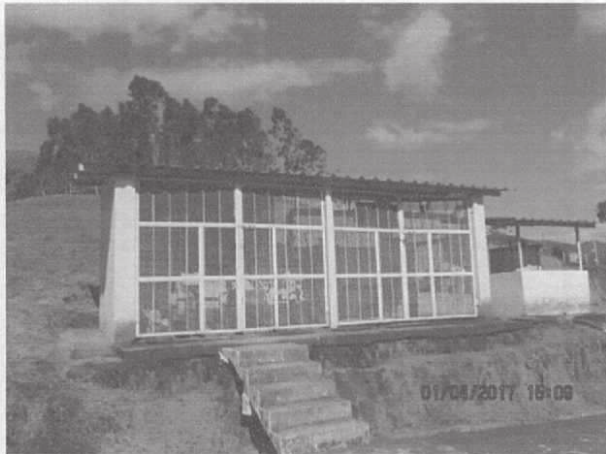
Casa do gerador
