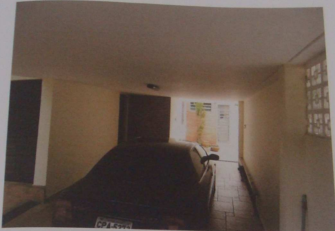
Foto nº 05 – Vista interna da garagem (cobertura), objeto da presente ação.
