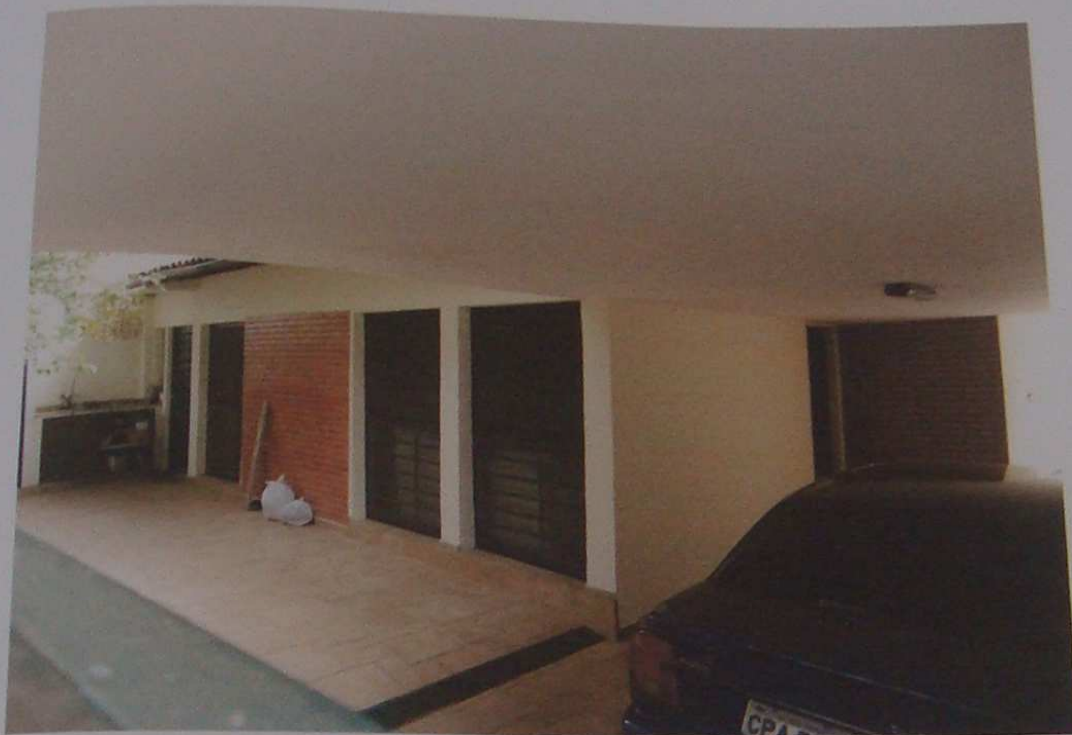
Foto nº 06 – Vista da garagem (vaga externa), objeto da presente ação.
