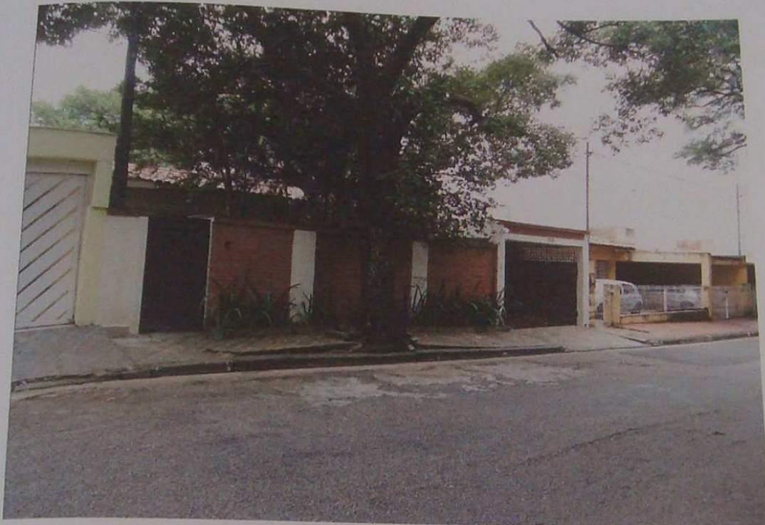
Foto nº 03 – Vista da fachada do imóvel, objeto da presente ação.
