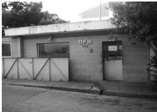
Detalhe da Fachada
