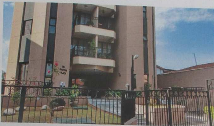
Foto 1 – Fachada Frontal Edifício Martins Plaza
