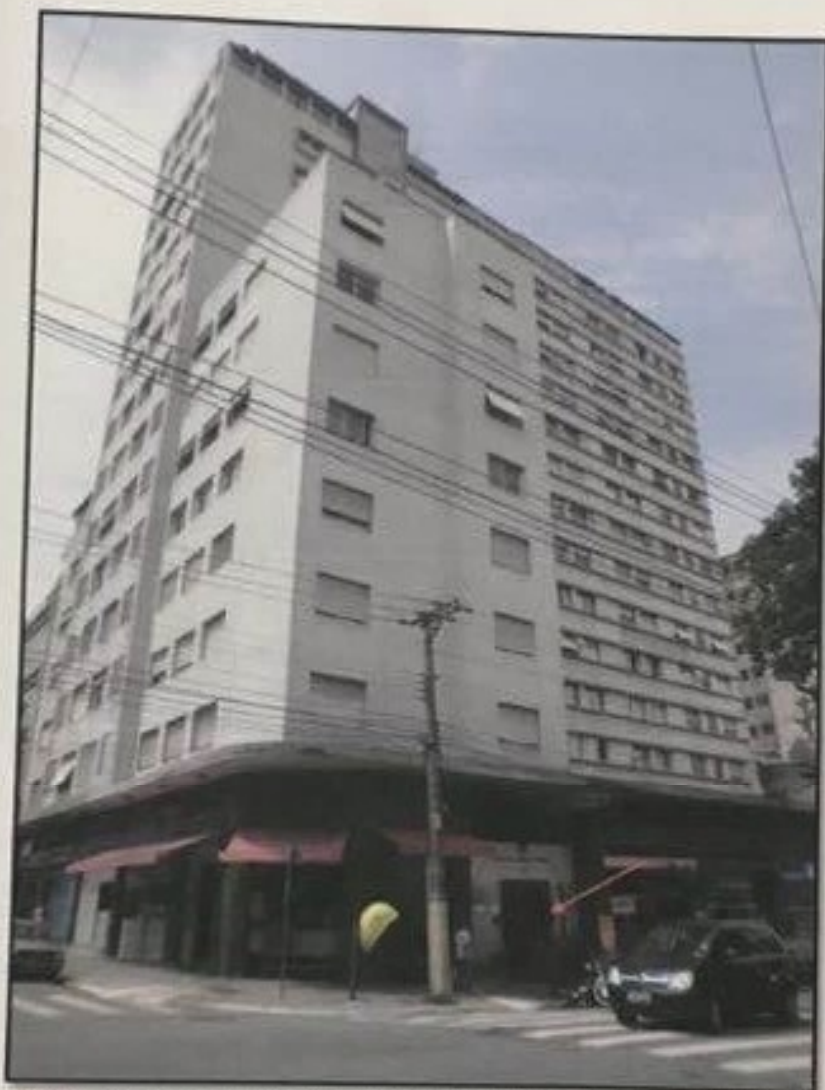
Foto 3 – Vista parcial da fachada do edifício Maria Vitória, a partir da Rua Conselheiro Nébias. Indicado na foto encontra-se a entrada do referido edifício.
