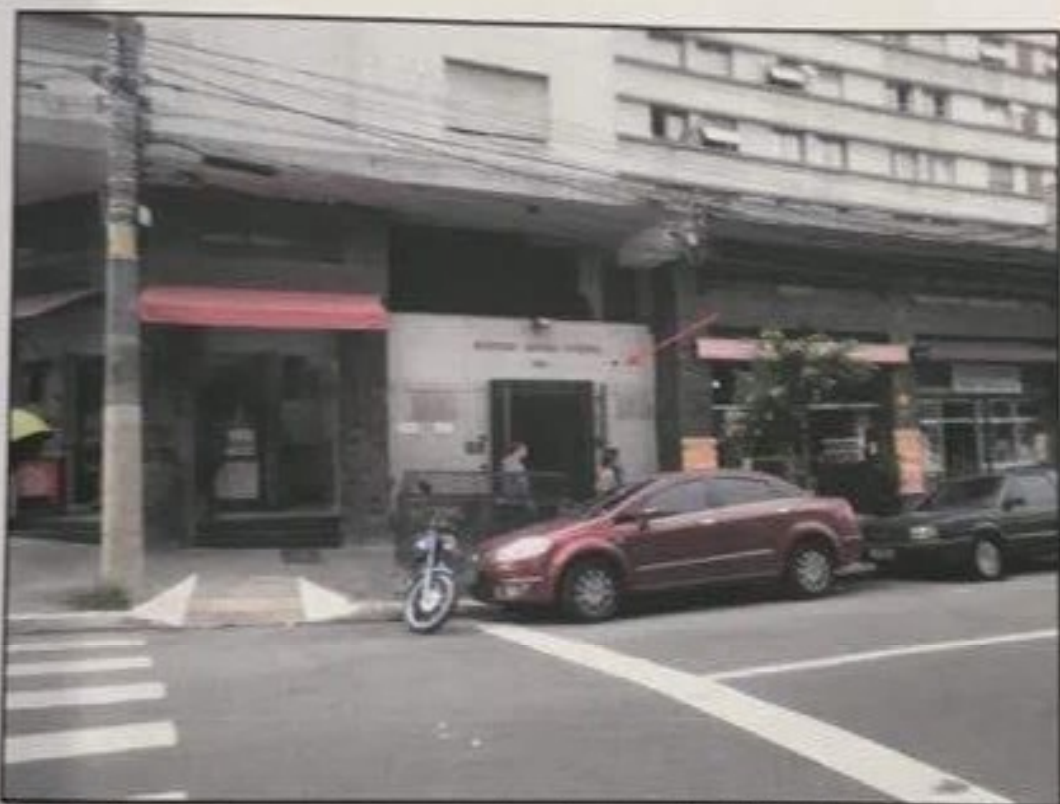
Foto 4 – Vista mais aproximada da entrada do Edifício Maria Vitória.
