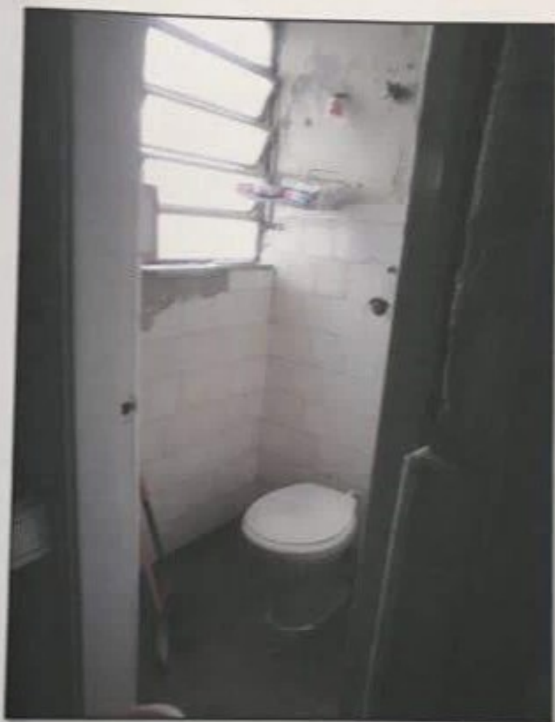
Foto 17 – Vista parcial do banheiro de serviço mencionado no foto anterior.
