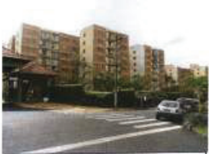
Vista parcial do Condomínio
