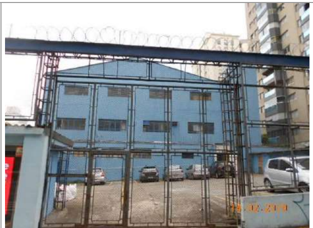
Fachada Lateral da Edificação – indicando “térreo + 02 pavimentos superiores”
