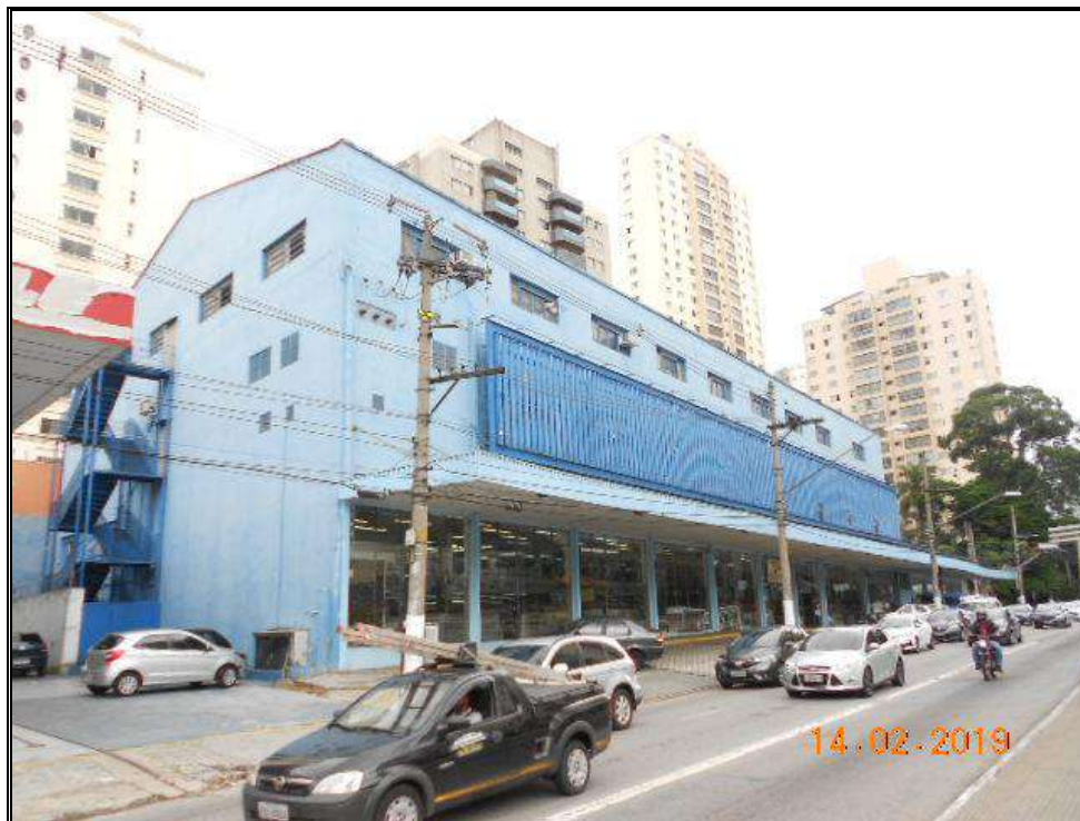
FACHADA DE TODO O IMÓVEL – OBJETO DE AVALIAÇÃO = 02 PARTES NÃO CONTÍGUAS
