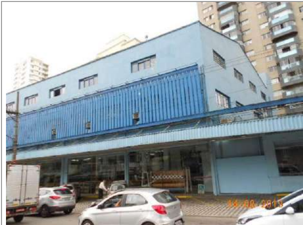
Frente da Edificação Total – nota-se a dificuldade de separação física de 02 partes não contíguas
