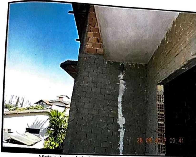
Vista externa do imóvel com etapas inacabadas
