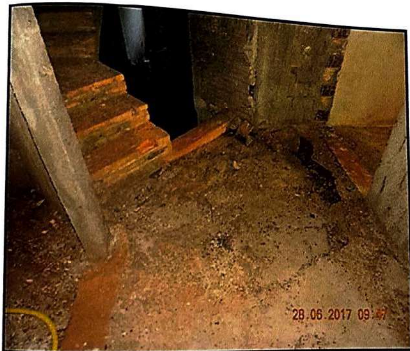
Vista do acesso ao pavimento inferior
