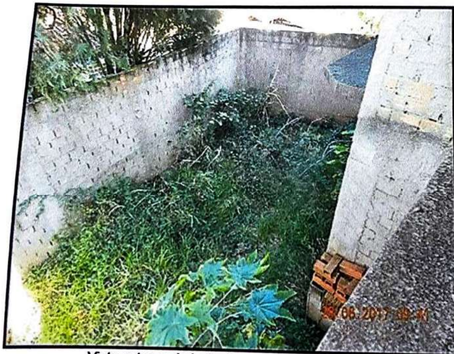
Vista externa do imóvel com etapas inacabadas
