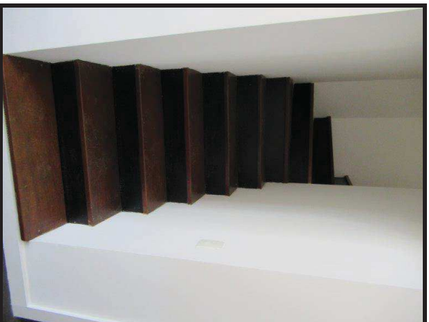
Foto 15: Escada de acesso ao 2º piso
