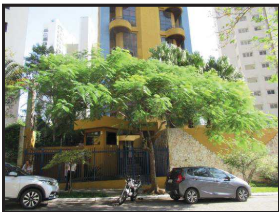
Foto 3: Edifício Summit Loft
