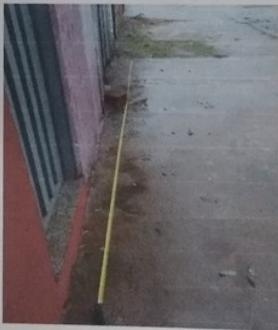
Foto 2 – Identificação do imóvel – Testada de 5,00 metros
