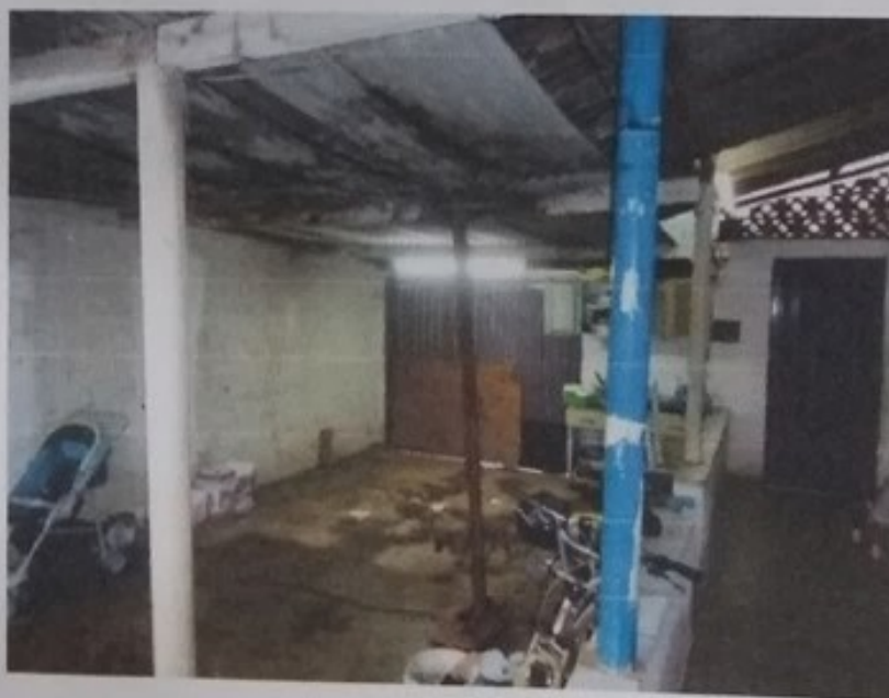
Foto 4 — Vista geral das benfeitorias no terreno avaliando
