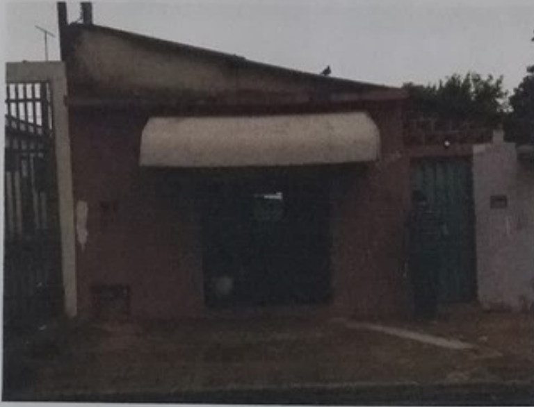
Foto 1 – Vista da fachada do imóvel pela Rua Medeiros de Albuquerque, n° 1658
