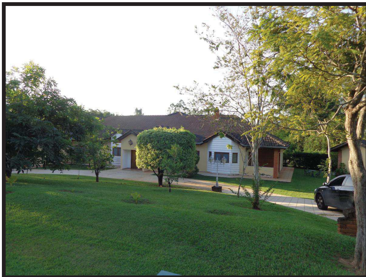
Vista frontal do imóvel avaliando.
