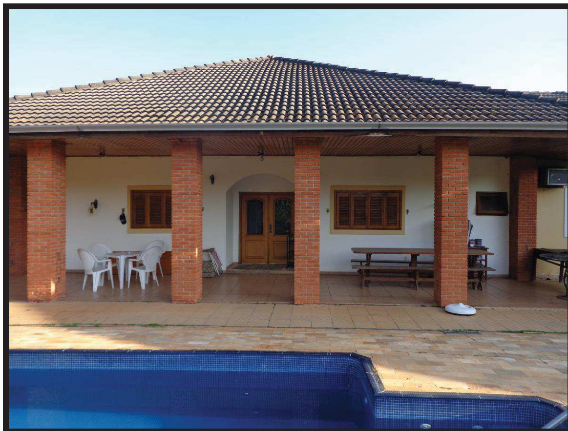
Vista dos fundos do imóvel avaliando.
