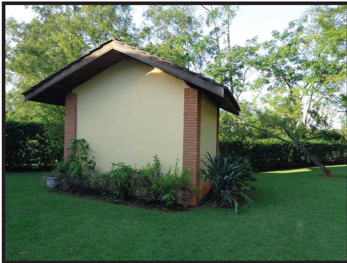
Vista da casa das máquinas do imóvel avaliando.
