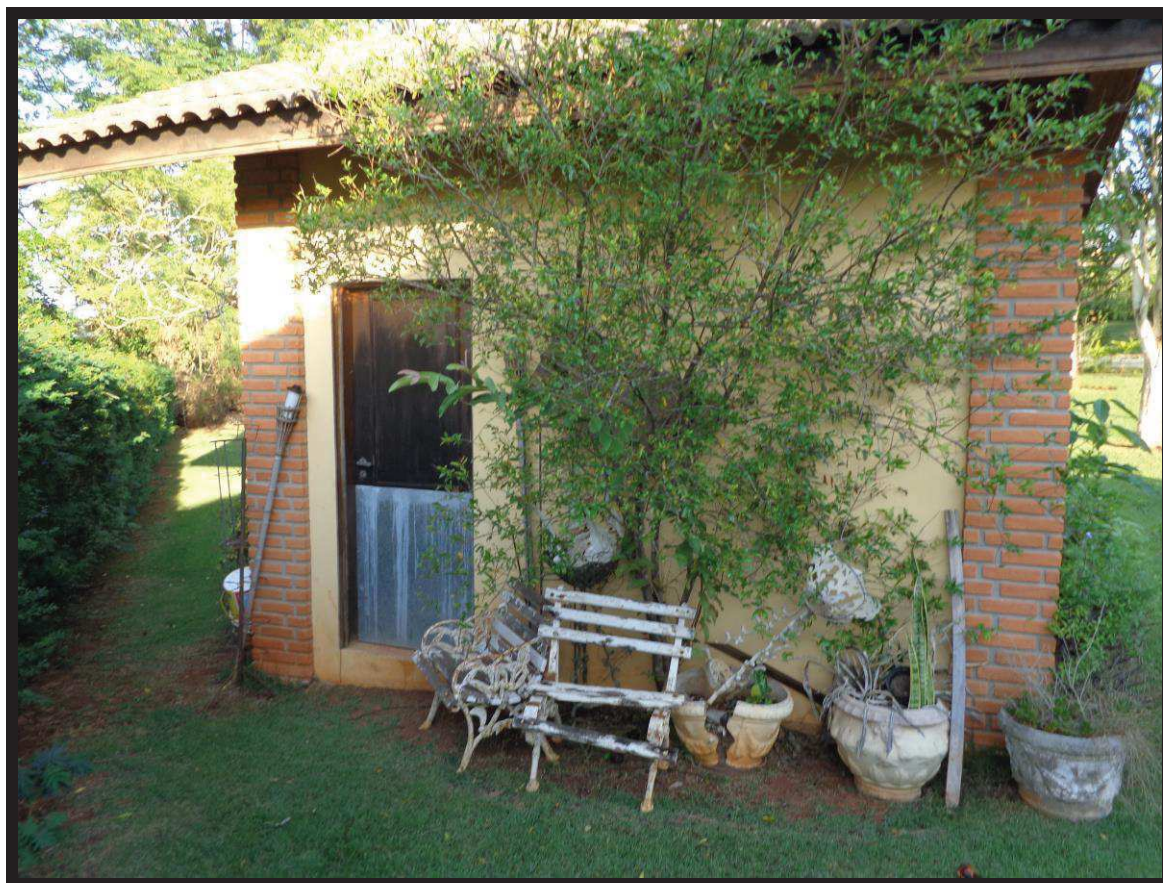
Outra vista da casa das máquinas do imóvel avaliando.
