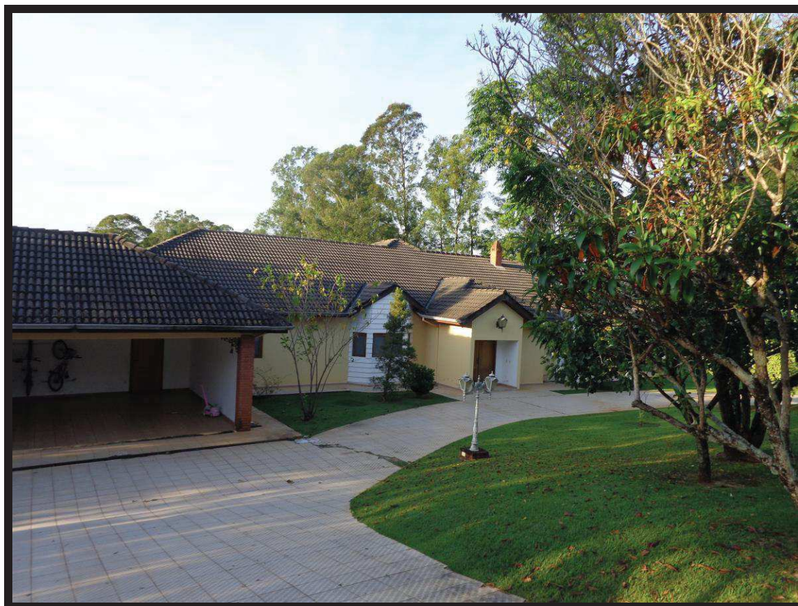
Outra vista frontal do imóvel avaliando.
