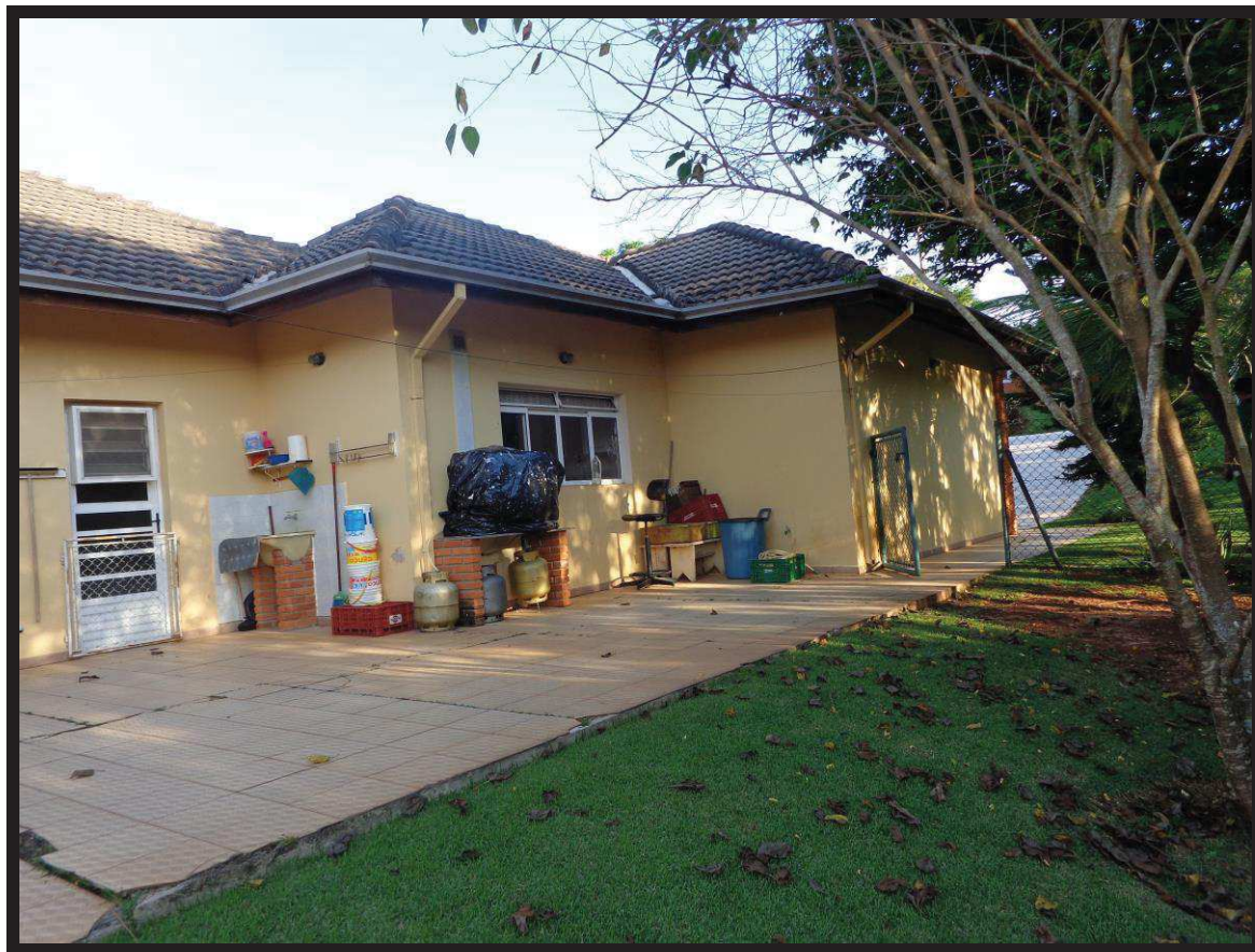
Vista dos fundos do imóvel avaliando.
