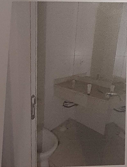
Foto 13 – Vista parcial do banheiro da suíte master.
