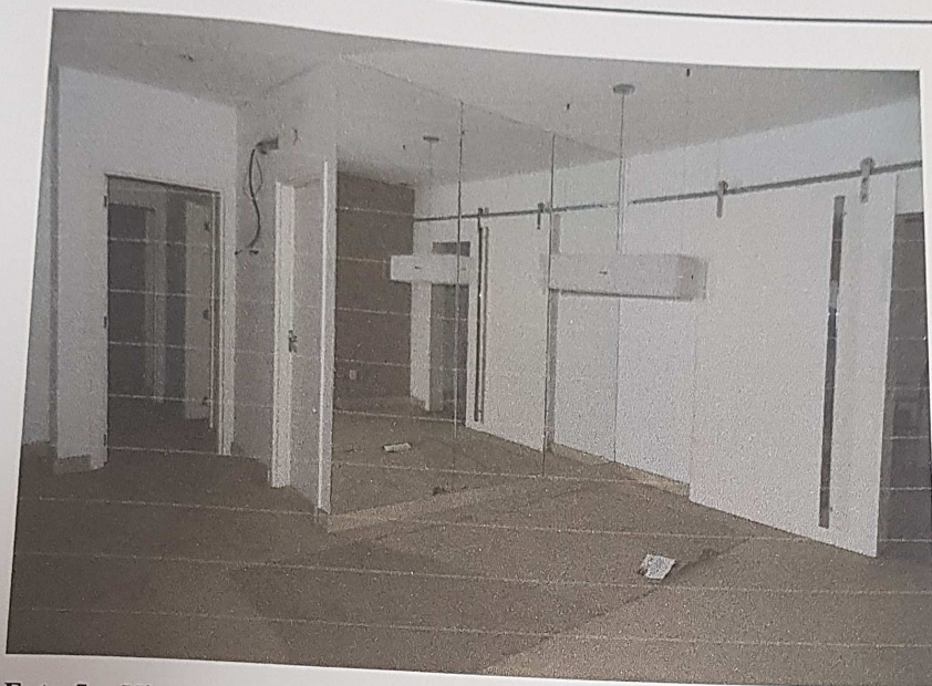
Foto 5 – Vista parcial da sala.
