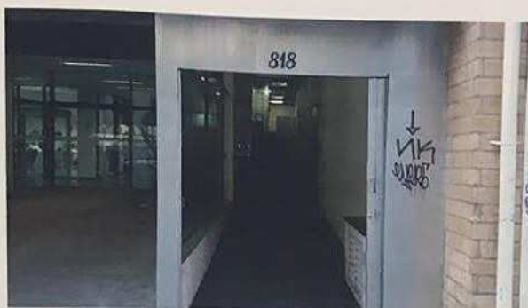
FOTO N° 02 Vista parcial Entrada Edifício Yara
