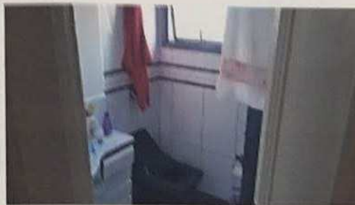
FOTO Nº 08 Vista parcial Banheiro suite
