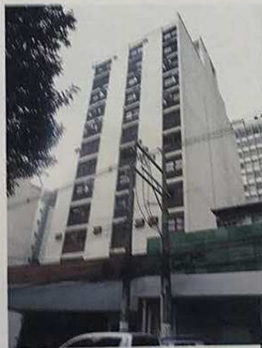
FOTO Nº 01 Vista parcial fachada Edifício Yara
