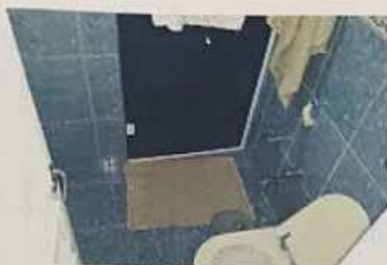
FOTO Nº 05 Vista parcial Banheiro
