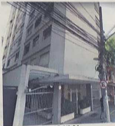
FOTO Nº 01 Vista parcial fachada do Edifício Alcacer
