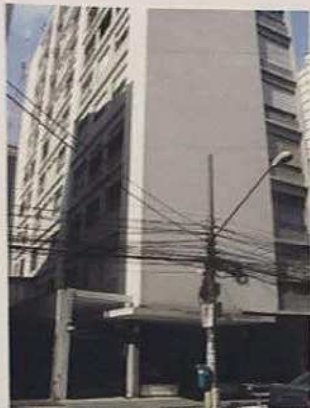
FOTO – VISTORIA EXTERNA Vista Parcial Fachada do Edifício Alcaçer
