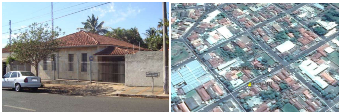
Casa residencial situada à Rua Floriano Peixoto, 278, Centro;
