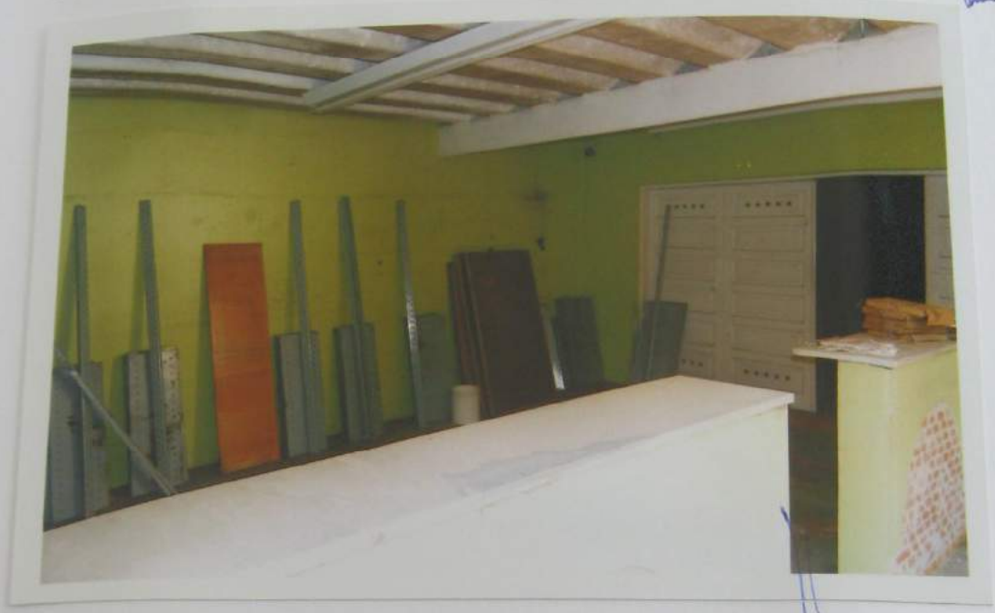
Foto de nº 20 - Outra vista da área externa das edificações dos fundos. 99/10/2000
