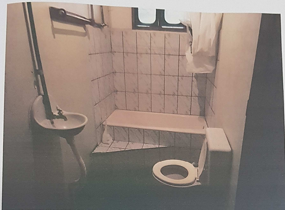
Foto 14: Vista do banheiro da edificação principal do imóvel ora avaliando.
