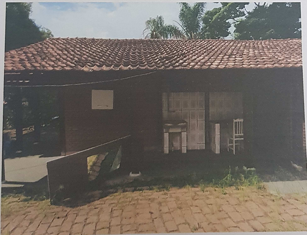
Foto 13: Vista lateral da edificação principal do imóvel ora avaliando.
