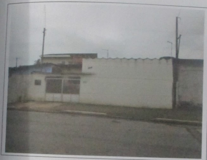
Fotos 01 – Vista do Imóvel em Questão
