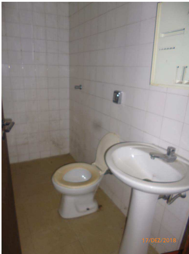
Foto nº. 31 – Vista do banheiro de serviço.
