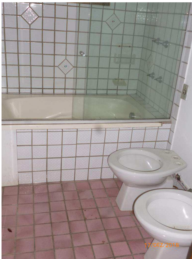
Foto nº. 37 – Vista do banheiro suíte 2.
