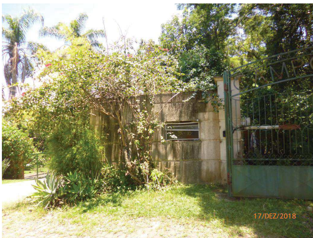
Foto nº. 6 – Vista da fachada da guarita.
