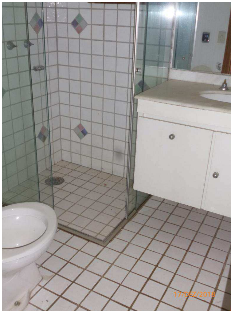
Foto nº. 39 – Vista do banheiro suíte 3.
