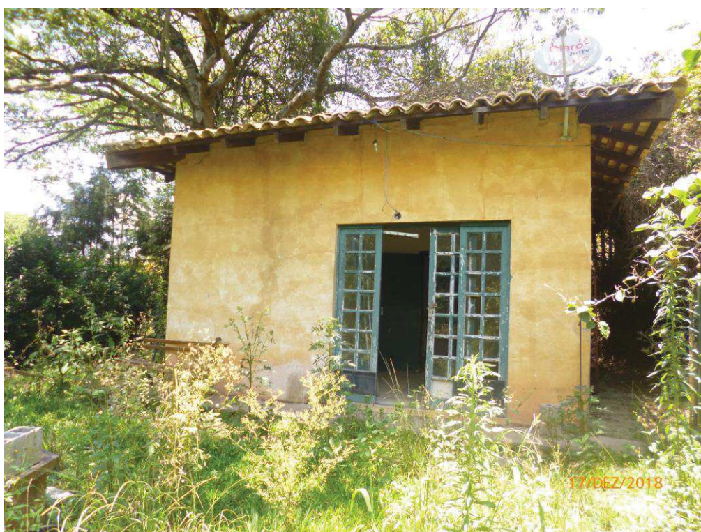
Foto nº. 45 – Vista da fachada.
