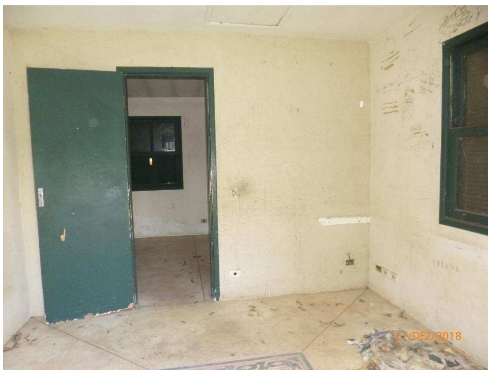
Foto nº. 47 – Vista do dormitório.
