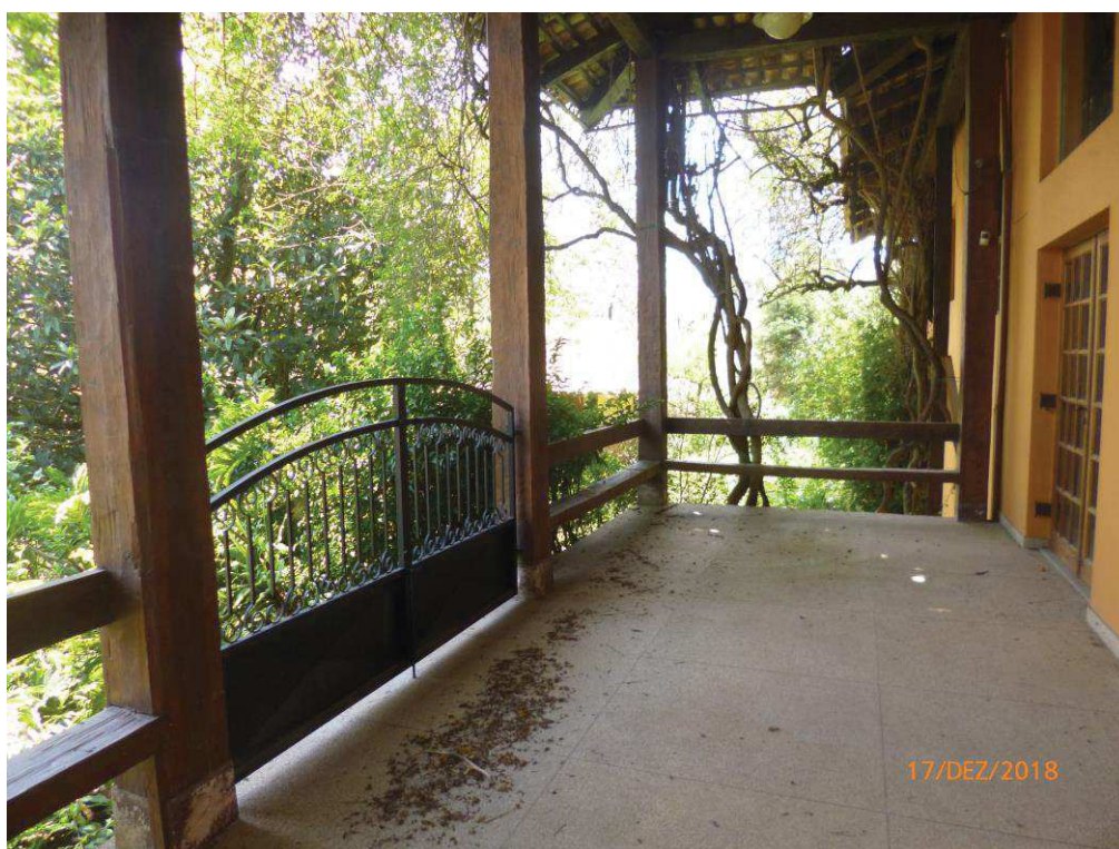
Foto nº. 20 – Vista da varanda.
