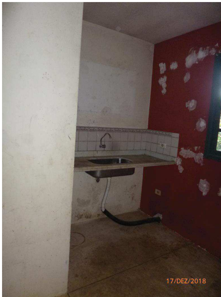
Foto nº. 48 – Vista do banheiro suíte 2.
