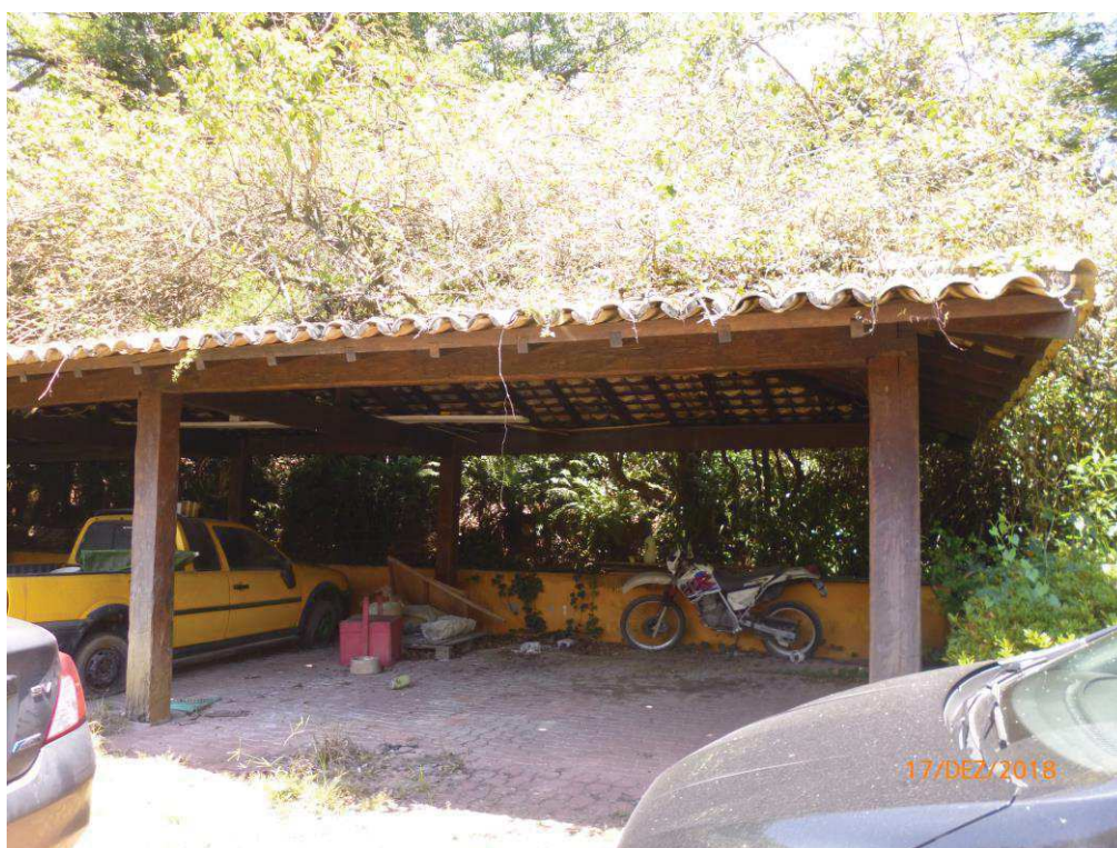
Foto nº. 7 – Vista da área de guarda de veículos.
