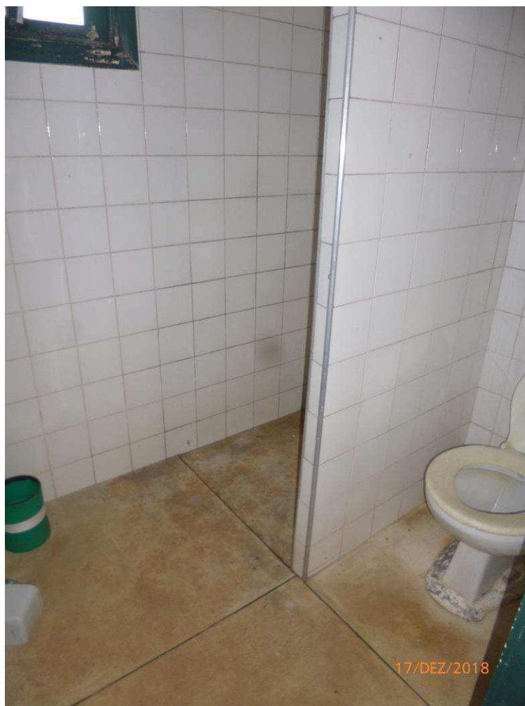
Foto nº. 49 – Vista do banheiro.
