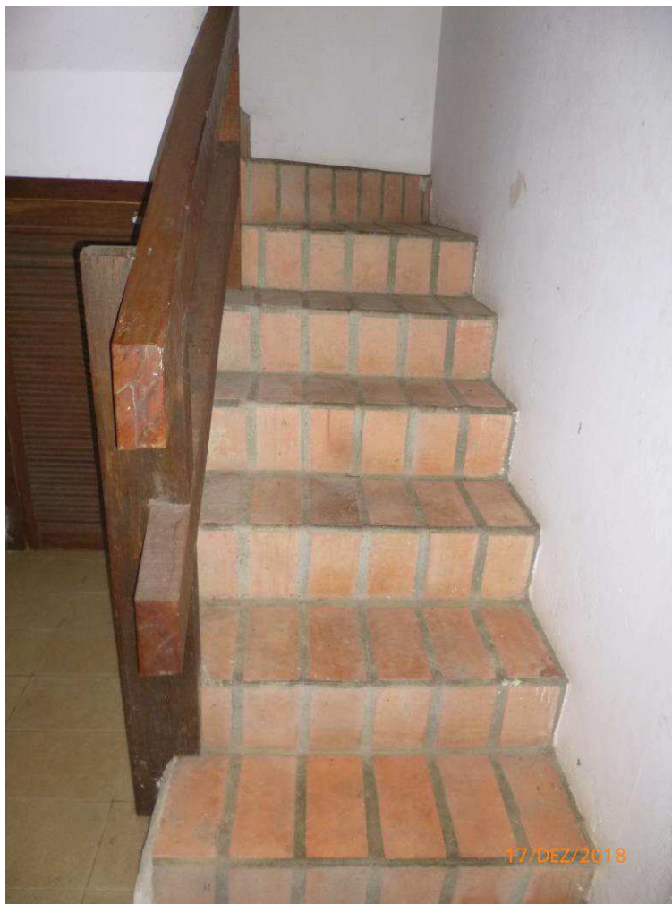
Foto nº. 29 – Vista da escada de acesso a área de serviços.
