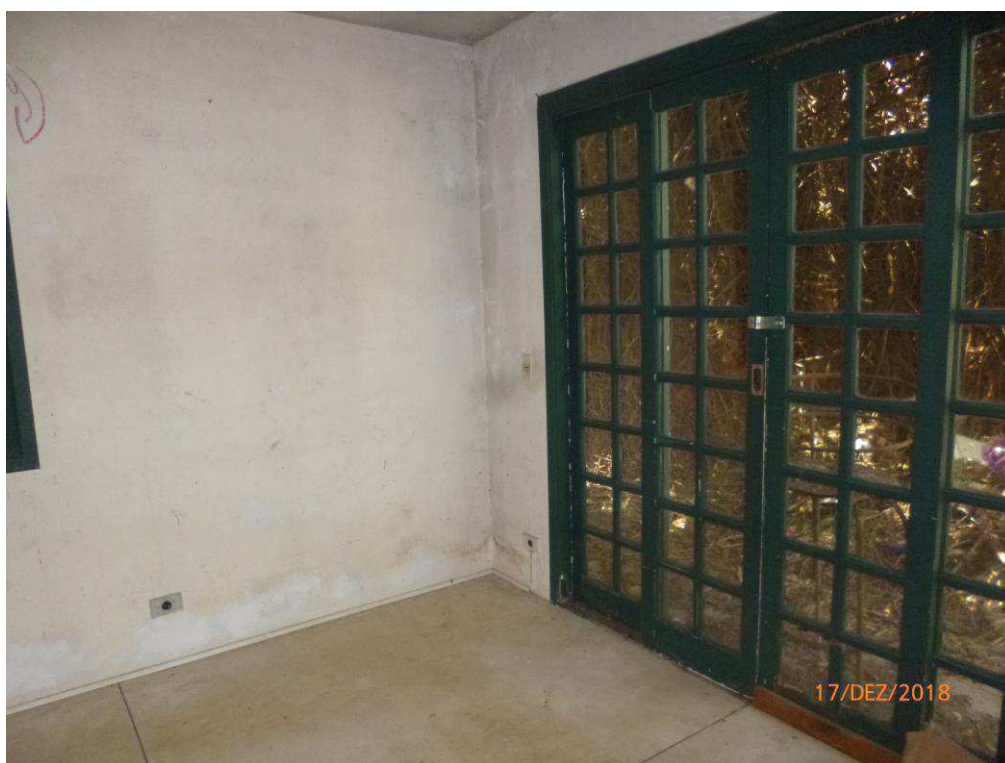
Foto nº. 46 – Vista da sala
