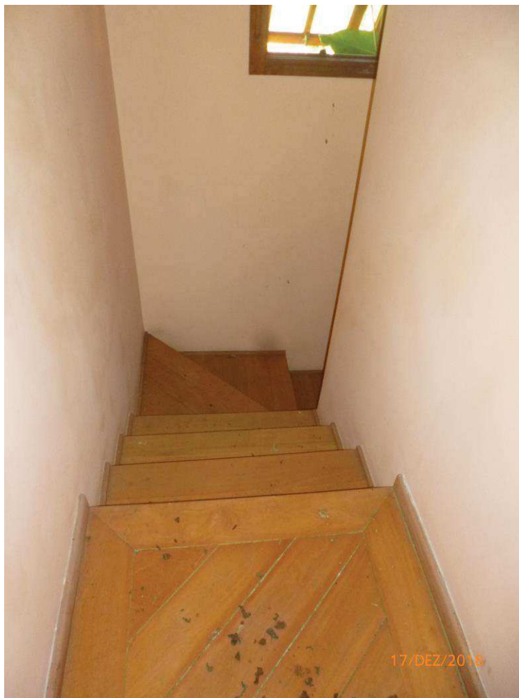
Foto nº. 41 – Vista da escada de acesso à suíte máster.
