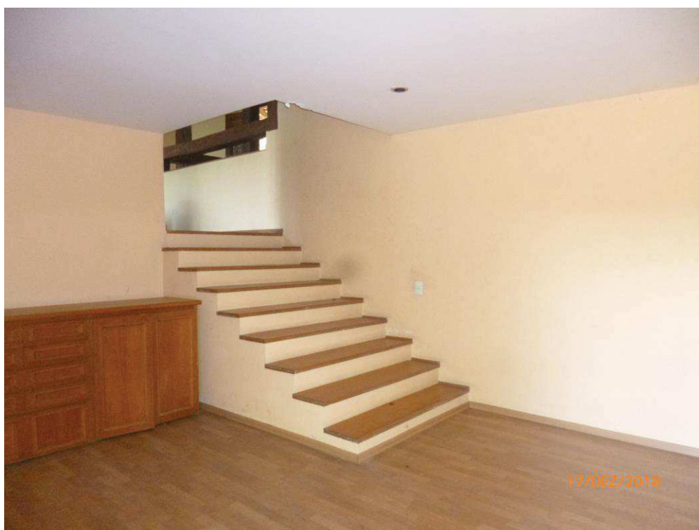
Foto nº. 21 – Vista da escada de acesso ao salão.
