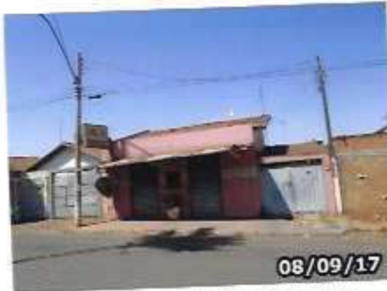
Vista parcial da fachada do imóvel
