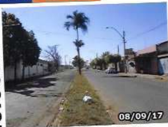
Vista parcial da avenida
