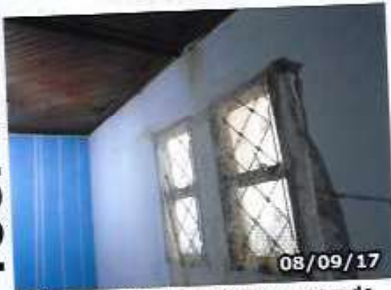
Vista parcial da sala forro, parede e janela
