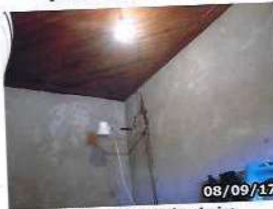
Vista parcial do banheiro
