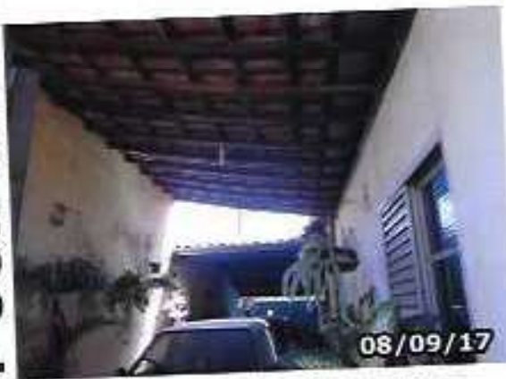
Vista parcial da garagem com telhado selado
