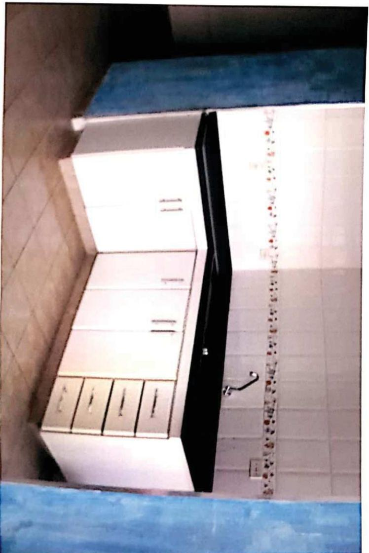
foto nº 12 - cozinha com piso e paredes de cerâmica, pia inox com tampo de granito e armários de madeira.
