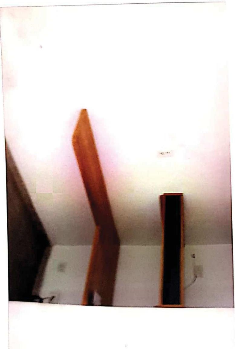
foto nº 11 –detalhe das paredes da sala/dormitório com massa corrida e látex
