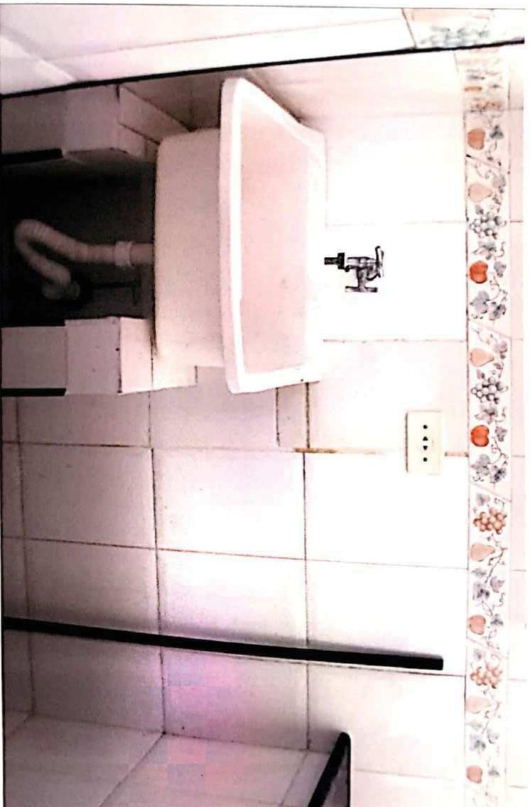
foto nº 12 - área de serviço com piso e paredes de cerâmica, tanque de lavar de pvc
