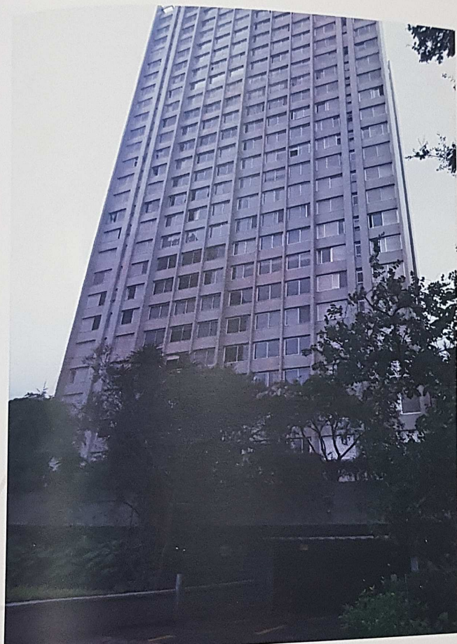
FOTO 7: FACHADA DO EDIFÍCIO.
