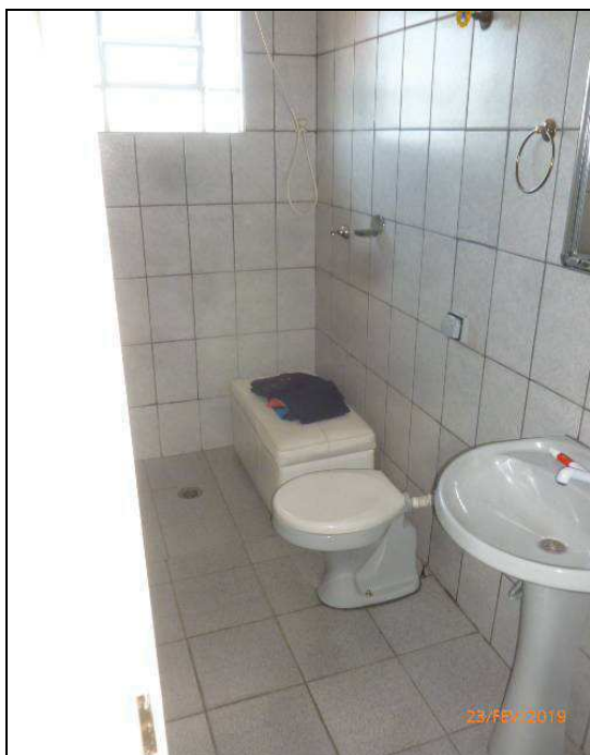
Foto n.º 7. Vista do banheiro da suíte, pavimento superior do corpo principal.
