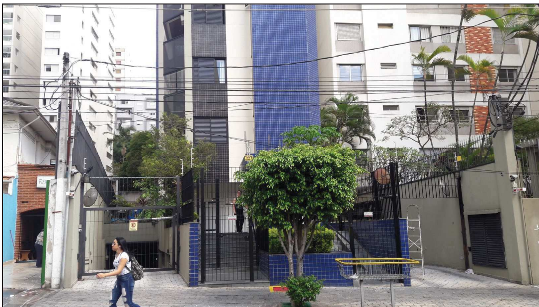
Foto 1 – Fachada do Edifício Capri
