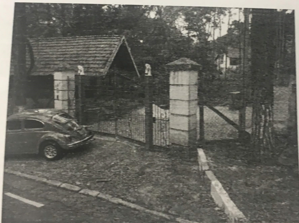
Foto Vista Frente do Lote 59 e 60 da Quadra 15 do Loteamento Cinco Lagos de Santa Maria - Alameda dos Pinheiros
