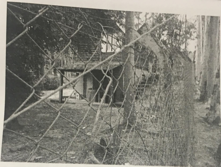
Foto Vista Frente do Lote 59 e 60 da Quadra 15 do Loteamento Cinco Lagos de Santa Maria
