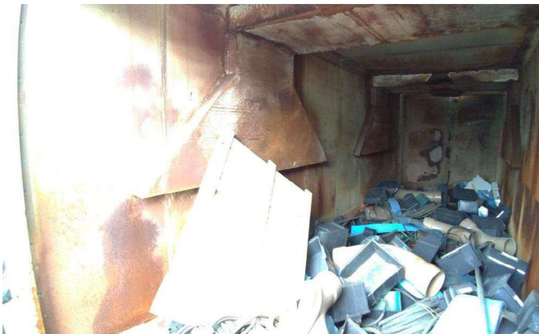
FOTO 21 – Cabine de Pintura - Interno
