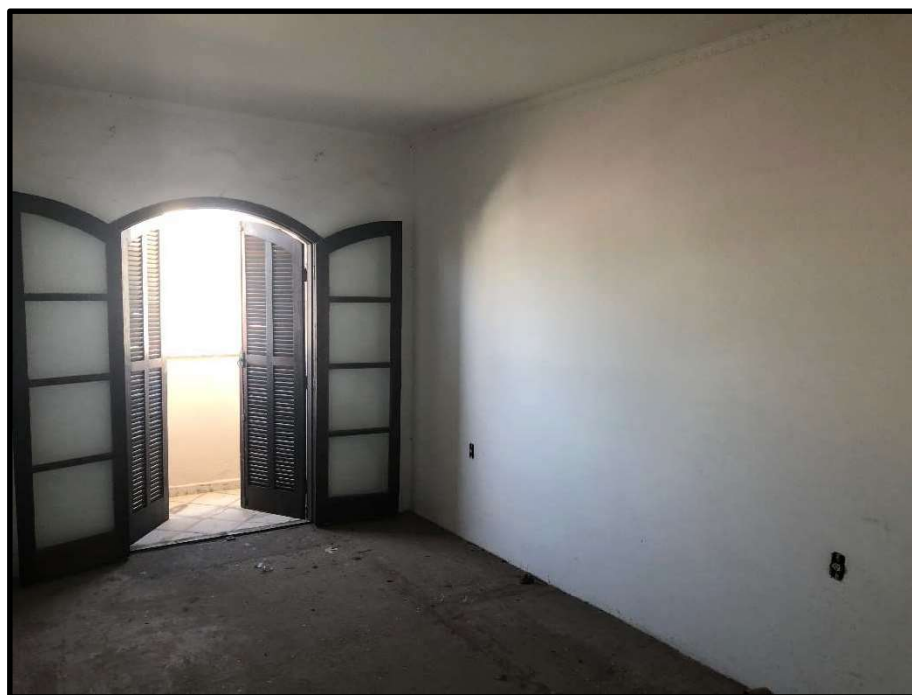
Foto 8 – “EDIFÍCIO FENÍCIA” – Apartamento 68 – Dormitório 1
