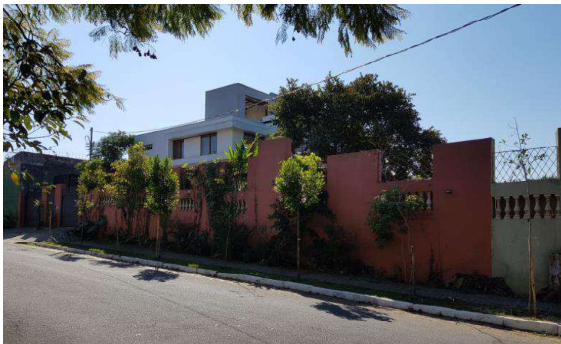
FOTO Nº 01 Vista parcial fachada do Sobrado
