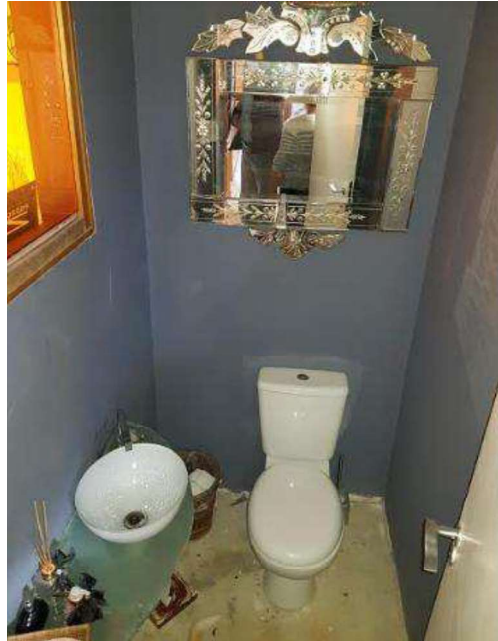
FOTO Nº 10 Vista parcial lavabo
