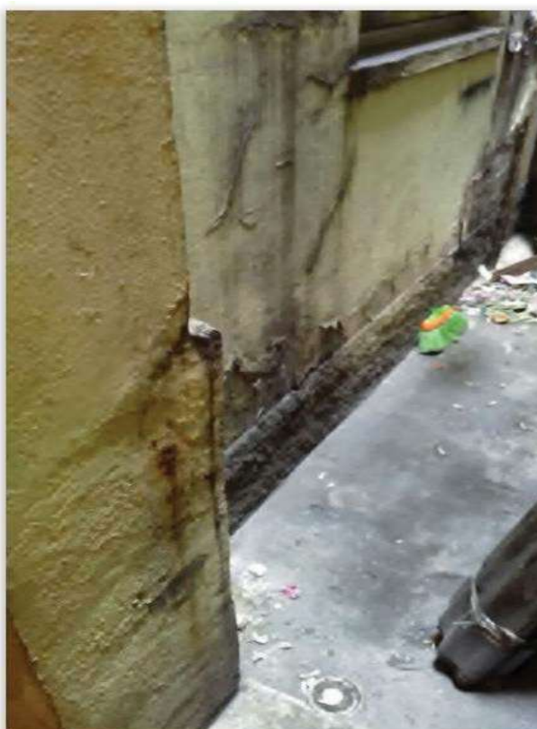
Foto 14 - Vista da lavanderia do imóvel vistoriado.
