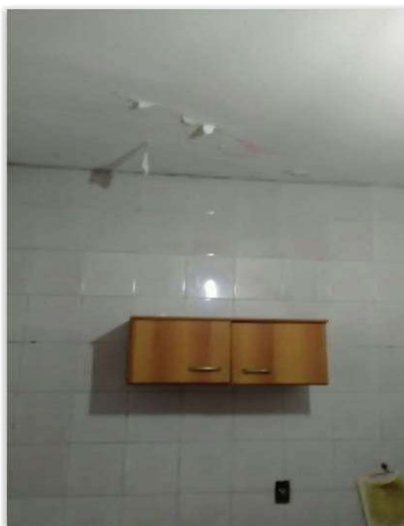
Foto 10 - Vista da cozinha do imóvel vistoriado.
