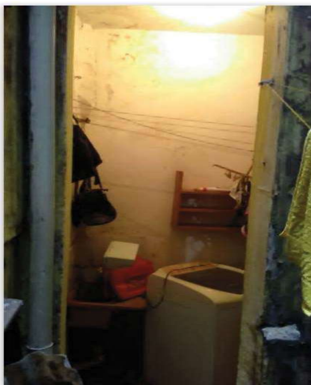
Foto 13 - Vista da lavanderia do imóvel vistoriado.
