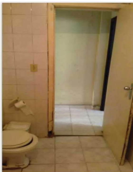
Foto 12 - Vista do banheiro do imóvel vistoriado.
