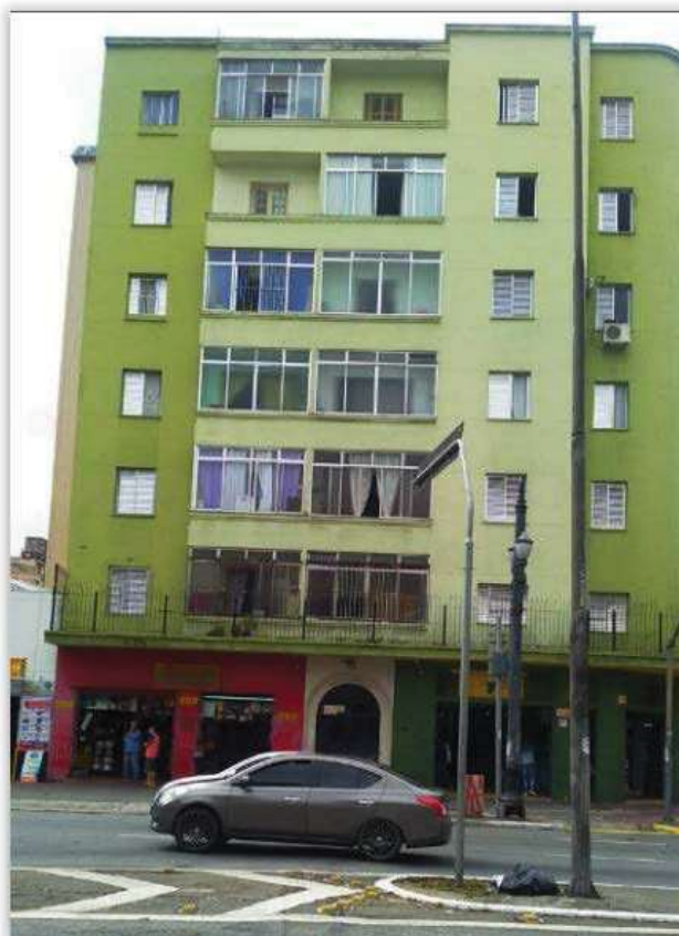
Foto 01 - Vista da fachada do condomínio.
