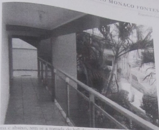
Acima e abaixo, tem-se a tomada do hall de entrada do Edifício em questão, onde nota-se piso em cerâmica, paredes e teto revestidos com massa fina pintada e guarda corpo de ferro e vidro.
