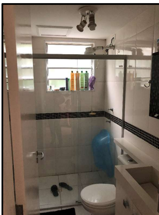
Foto 7 – “CONDOMINIO SPAZIO SAN VINCENT” – TORRE 3 – Apartamento 307 – Banheiro
