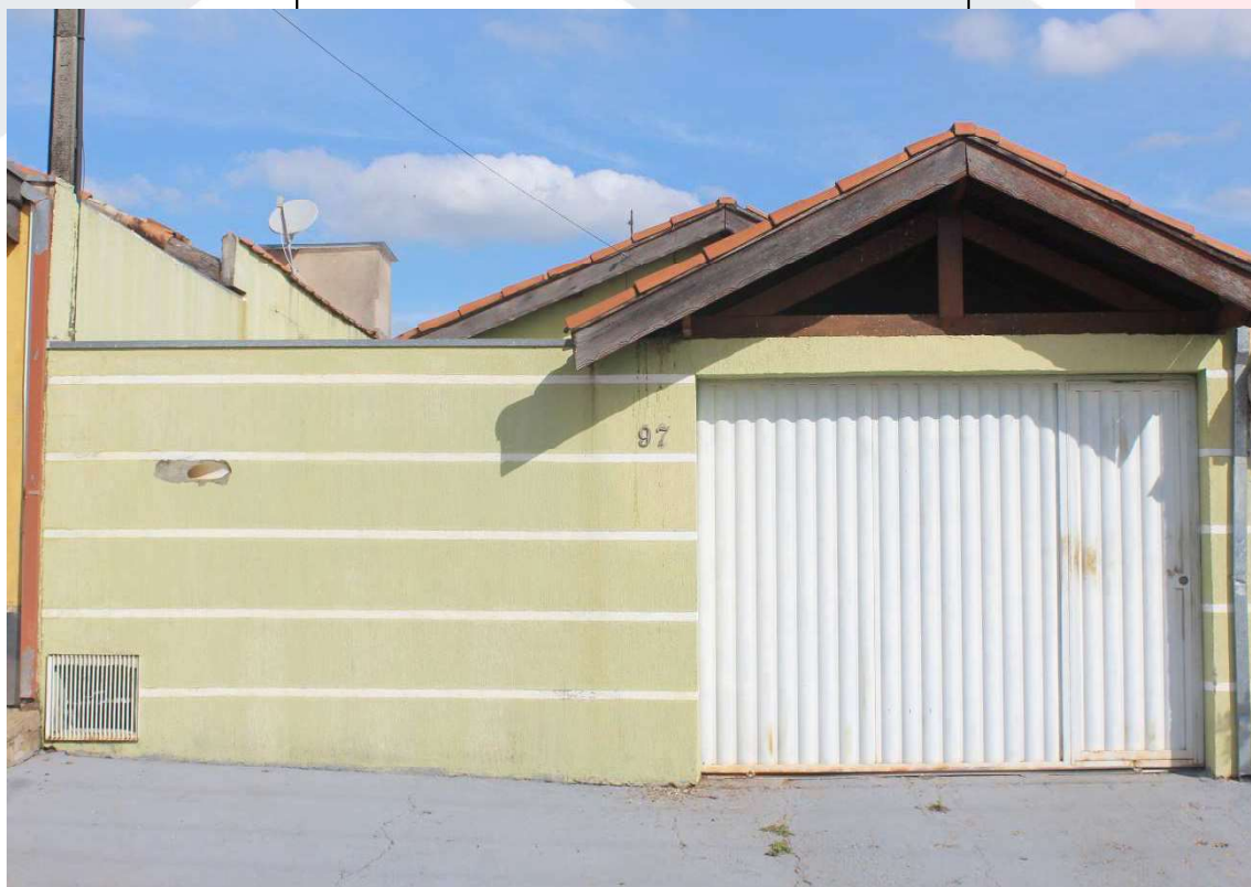
VISTA DO IMÓVEL AVALIANDO
