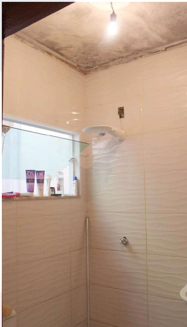
VISTA DO BANHEIRO SOCIAL.
