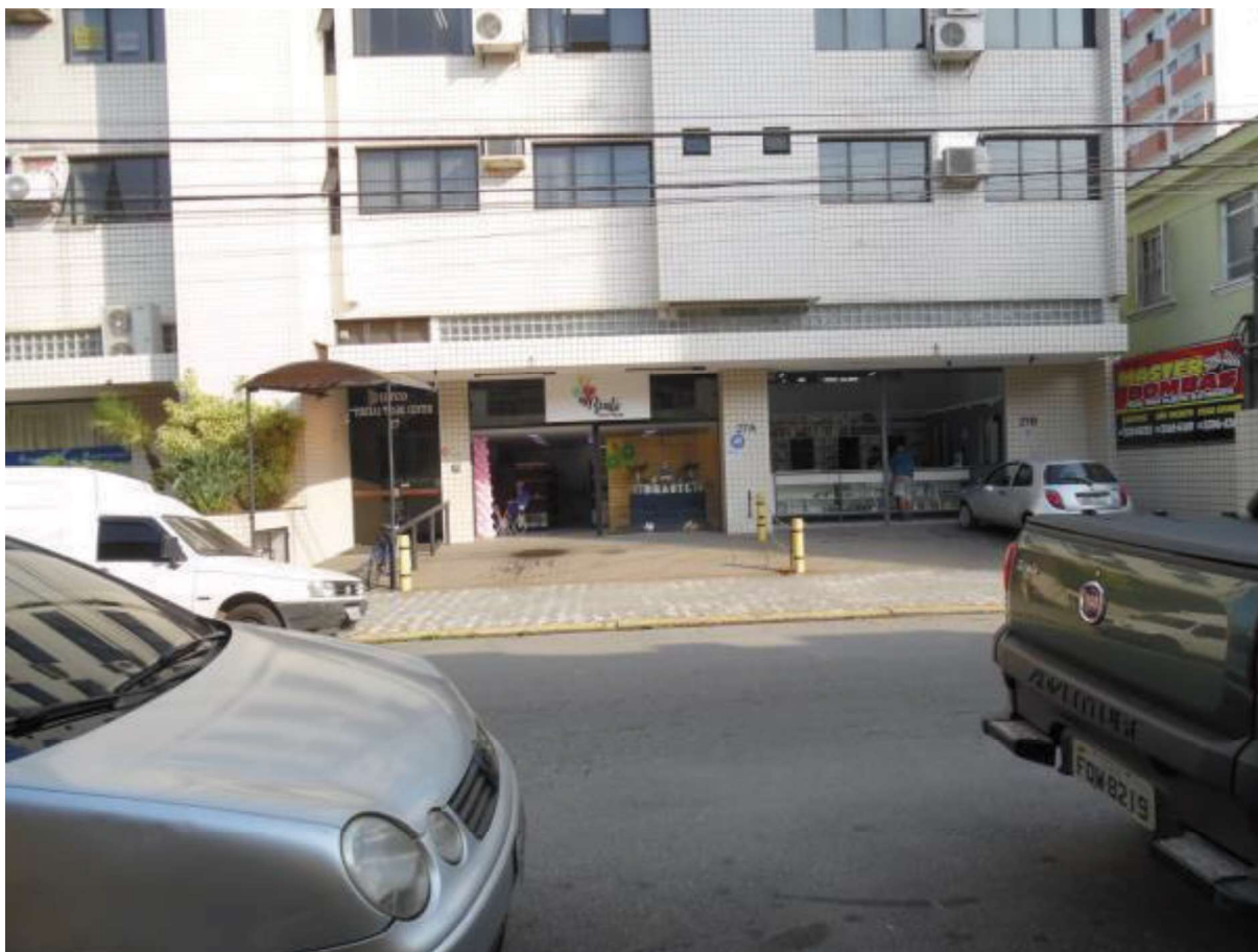
FOTO 03:- Vista da entrada do prédio.
