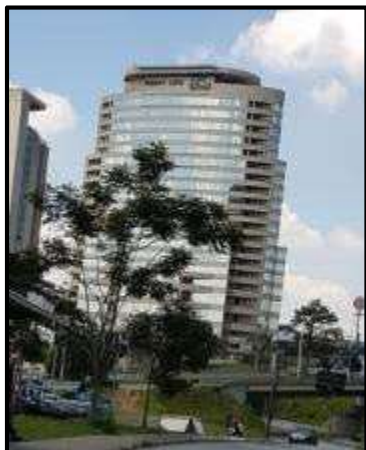
Vista geral do edifício
