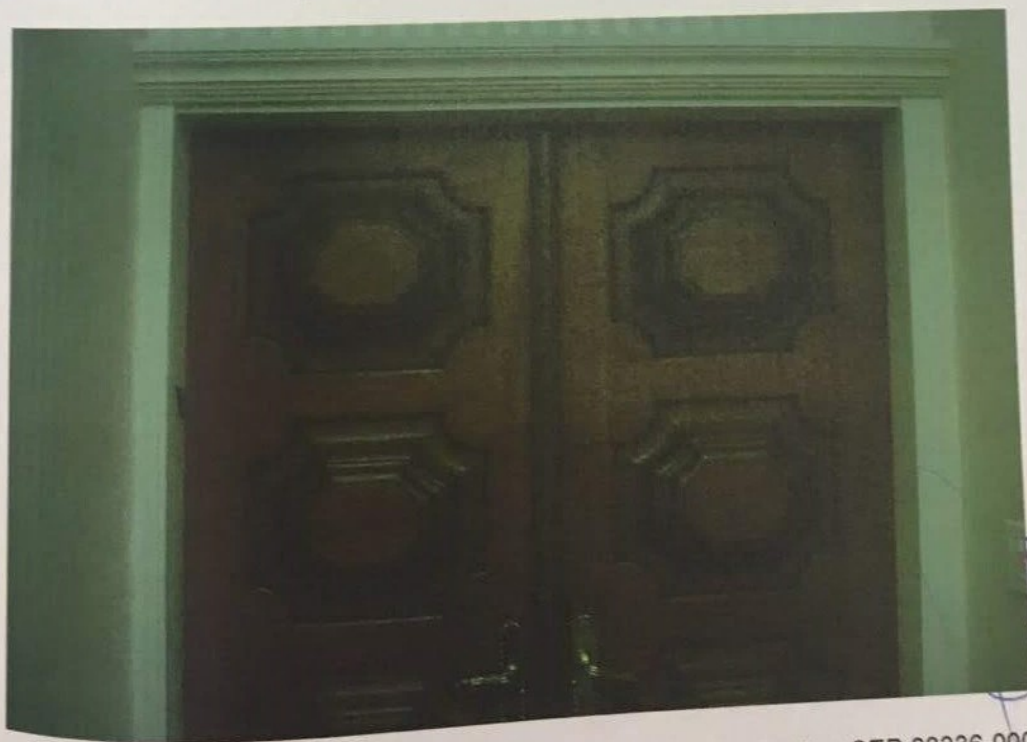
FOTO Nº 06 – Vista da porta de entrada no apartamento avaliando.
