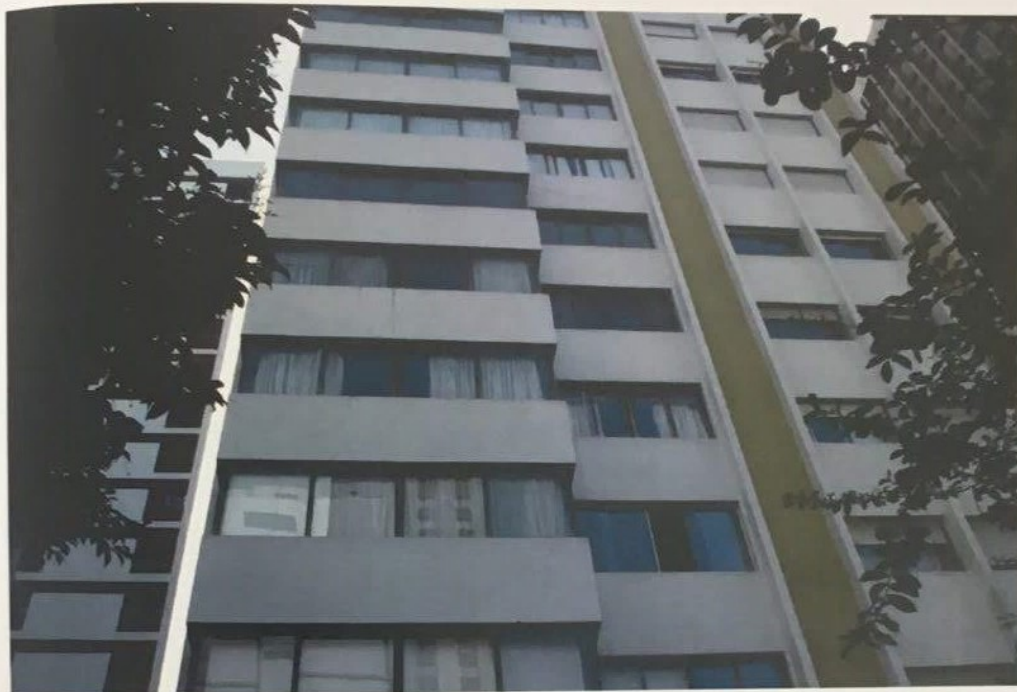
FOTO Nº 01 – Vista da fachada do Edifício Paola.
