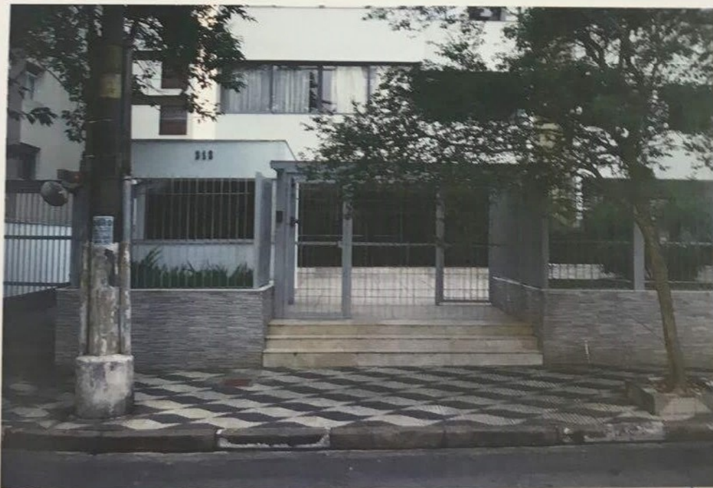
FOTO Nº 04 – Vista da portaria no Edifício Paola.
