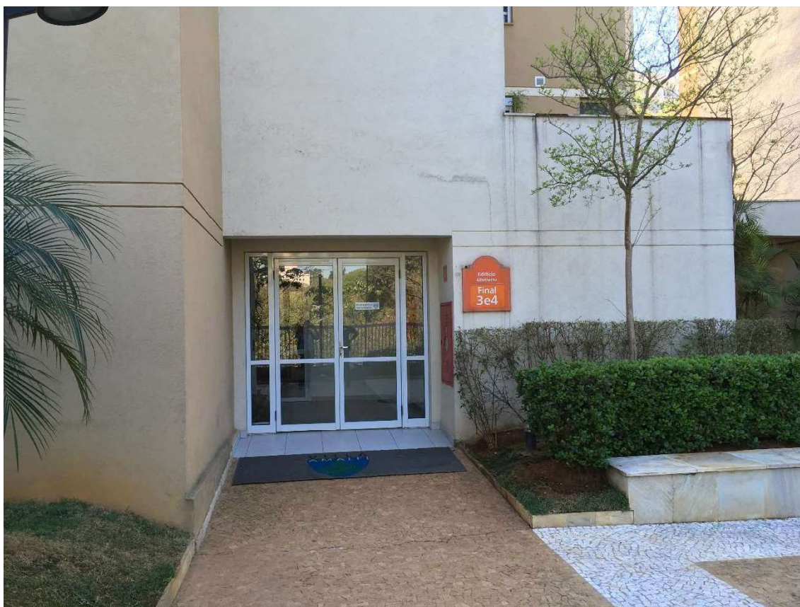
FOTO 10: Vista da Entrada do Edifício Giuliano.
