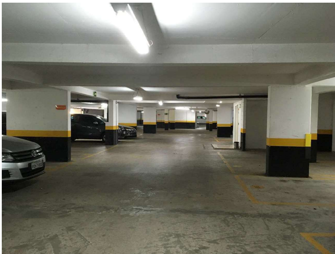
FOTO 12: Vista da Garagem.
