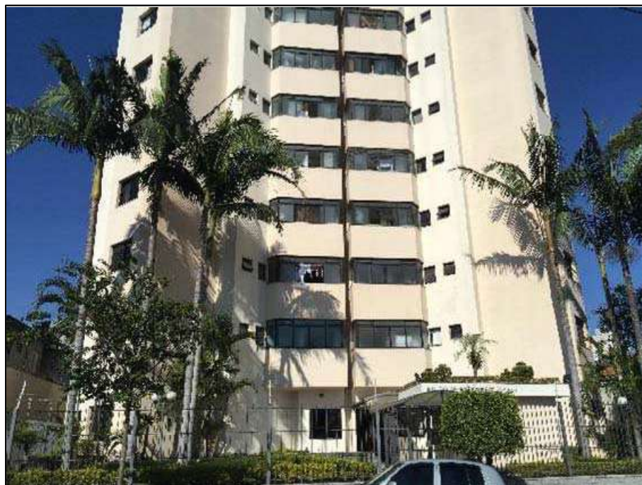
Foto 01. Fachada do condomínio do imóvel avaliando.
