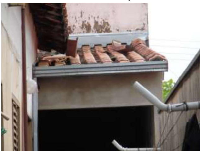
Foto 5 – Vista da cobertura dos fundos.
