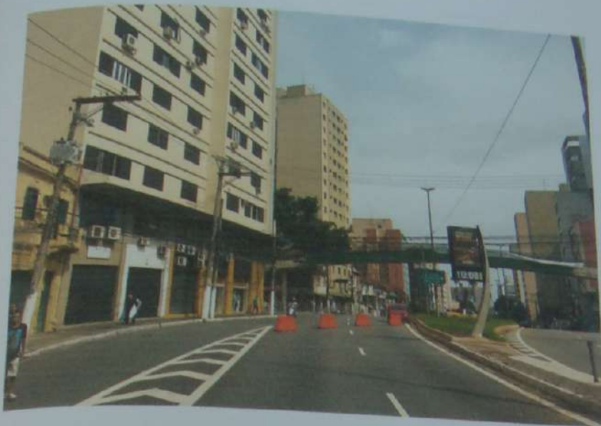
Largo Padre Péricles, com o Edifício João Duarte Junior à esquerda, visto do início da Via Elevada Pres. João Goulart.
