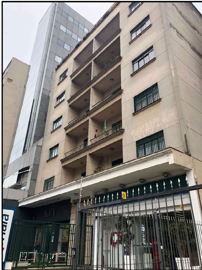
Foto 1: Fachada do Edifício Castro Prado
